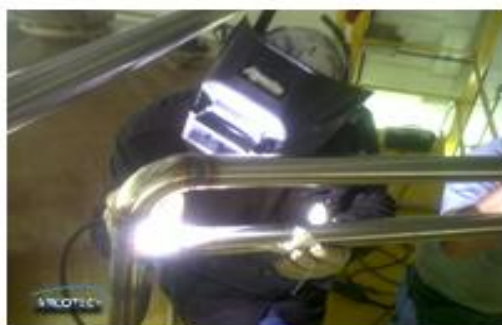
INSTALACIÓN DE LÍNEAS SEGÚN INGENIERÍA HIGIÉNICA Cambio de tuberías no sanitarias; acero inoxidable sanitarias
